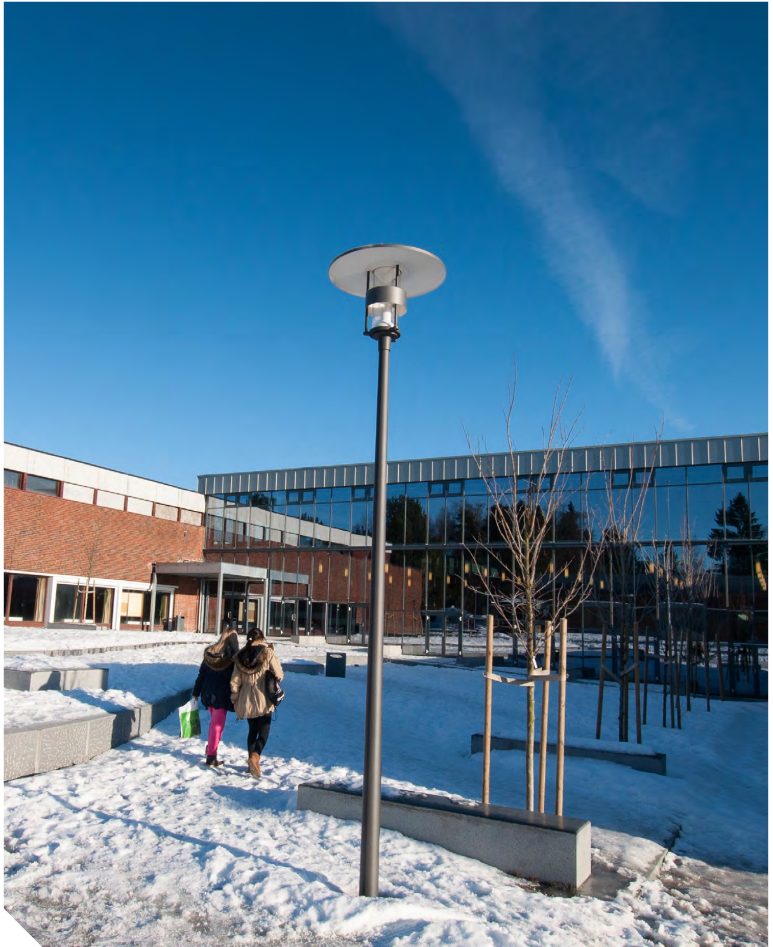
Kjenn skole ble offisielt åpnet i april 2012 etter rehabilitering og nybygging. Fotograf: Nicolaas Kuipers
